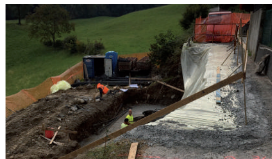
Lavori di consolidamento stradale in via Matteotti
