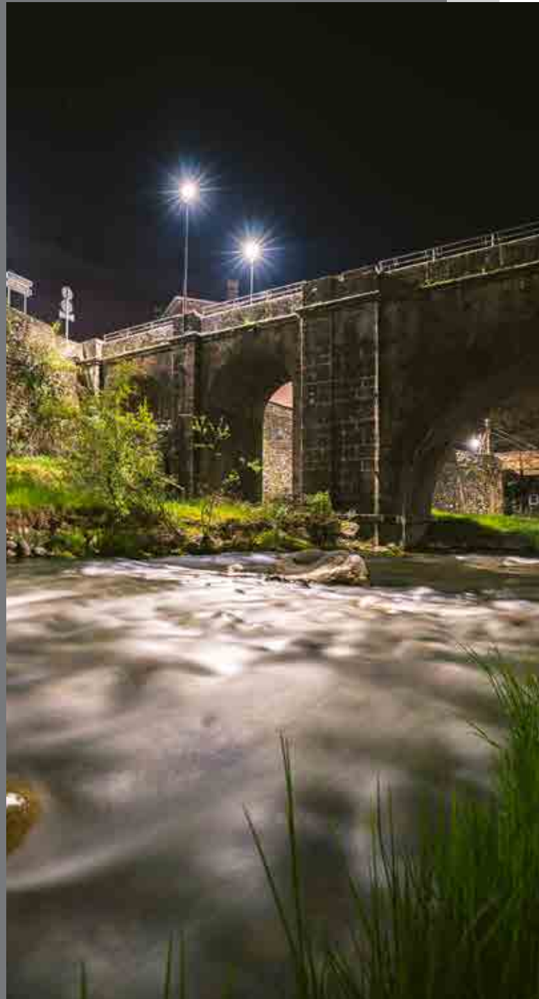
Veduta notturna del ponte sul torrente Borlezza Night view of bridge over the Borlezza Stream
